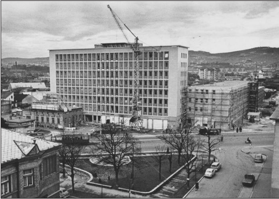
Die Baustelle am Wiener Höchstädtplatz Ende Dezember 1955.
