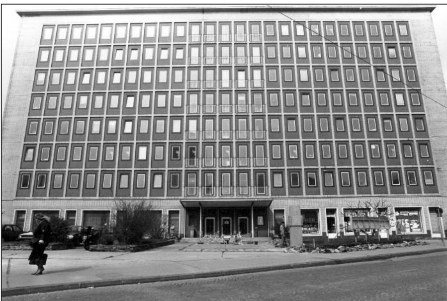
Die Fassade des Globus-Hauses 1989.
