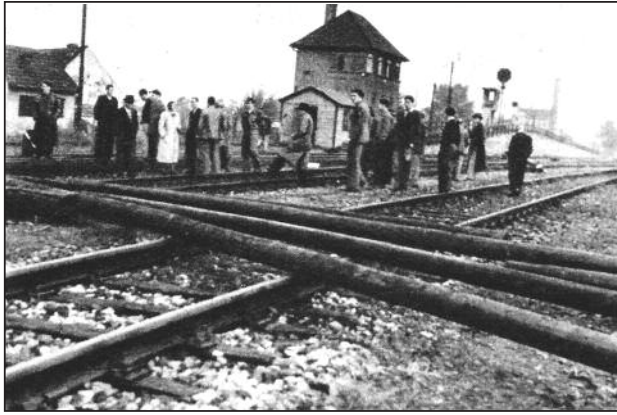
Sperre der Ostbahnstrecke in Wien-Stadlau
